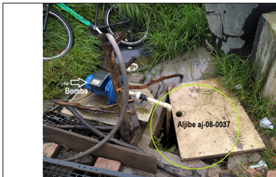
Foto No. 12. Vista general del aljibe
