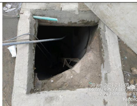
Foto No. 7. Vista al interior del aljibe
