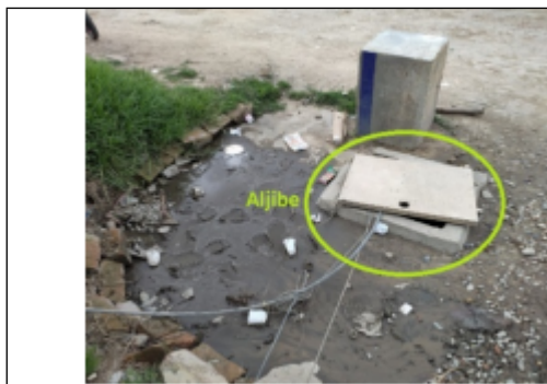
Foto No. 6. Vista general del aljibe
