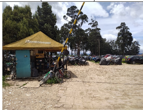
Foto No. 3. Vista entrada del parqueadero
