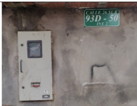
Foto No. 11. Dirección del parqueadero
