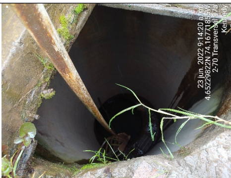
Foto No. 13. Vista al interior del aljibe
