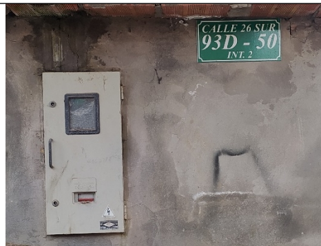
Foto No. 11. Dirección del parqueadero
