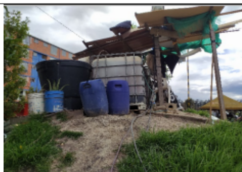
Foto No. 9. Tanques de almacenamiento
