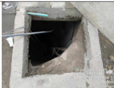
Foto No. 7. Vista al interior del aljibe
