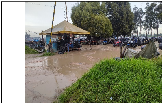
Foto No. 10. Vista entrada del parqueadero
