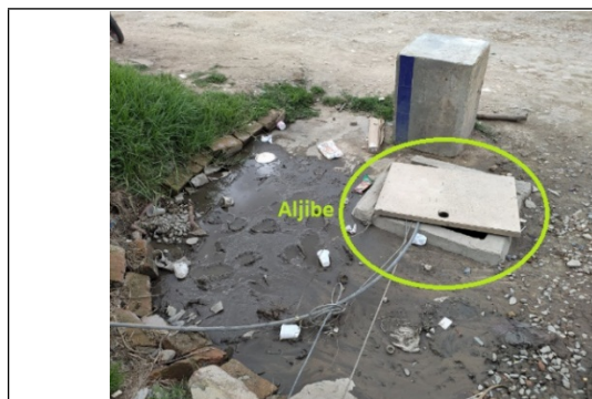
Foto No. 6. Vista general del aljibe
