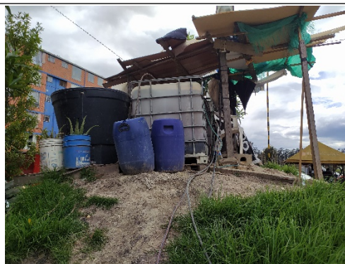
Foto No. 9. Tanques de almacenamiento
