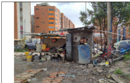
Foto No. 8. Compresor para extraer el agua subterránea
