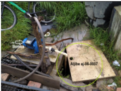
Foto No. 12. Vista general del aljibe
